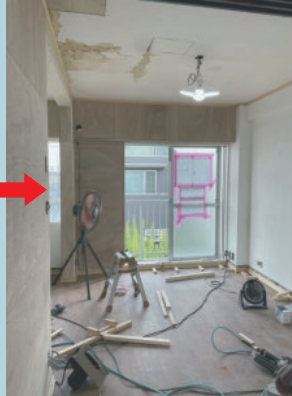
天井・床・壁一面のボードを隙間なく張り付けて、塗装をします。
