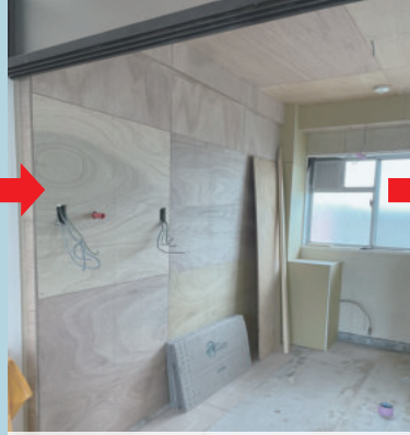
天井・床・壁一面のボードを隙間なく張り付けて、塗装をします。
