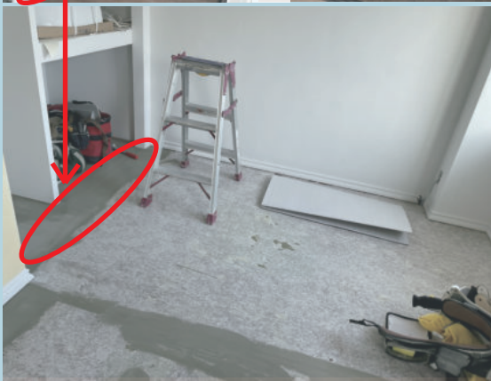
収納棚と部屋の境目をフラットにし、荷物の出し入れがしやすいように工夫をしています。
