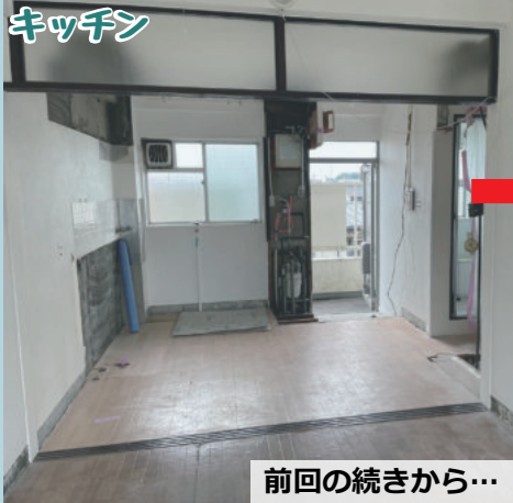
天井・床・壁一面のボードを隙間なく張り付けて、塗装をします。
